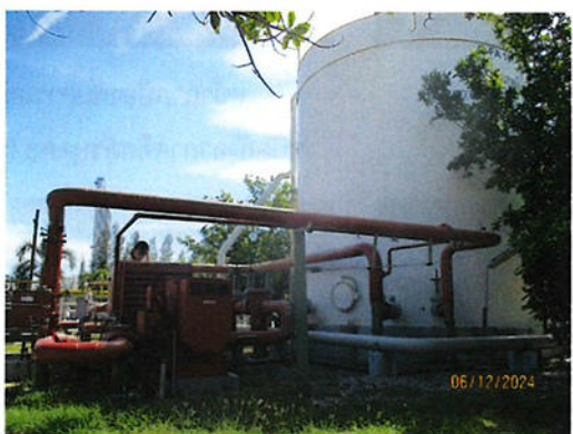
ถังน้ำดับเพลิง ขนาด 720 ลูกบาศก์เมตร
