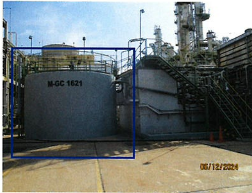
ภาพที่ 2-12 ป่อพักน้ำเสียที่ปนเปื้อนสารเคมี เป็นแบบ Double Containment
