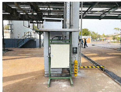
ภาพที่ 2-36 HCl Detector
