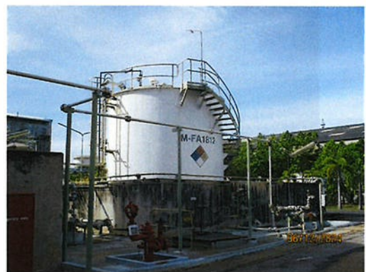
ภาพที่ 2-41 คันกั้นสำหรับถังเก็บกักภายในพื้นที่โครงการ
