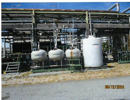
ภาพที่ 2-11 ระบบกรองทราย (Sand Filter) และระบบ RO (Reverse Osmosis)
