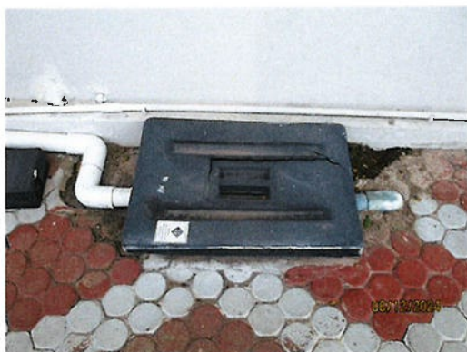
ภาพที่ 2-9 ที่ตัดไขมันและตะกั่วกรดตกขยะ บริเวณโรงอาหาร
