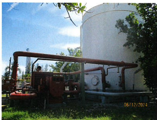
เครื่องสูบน้ำดับเพลิงดีเซล และ เครื่องสูบน้ำดับเพลิงไฟฟ้า
