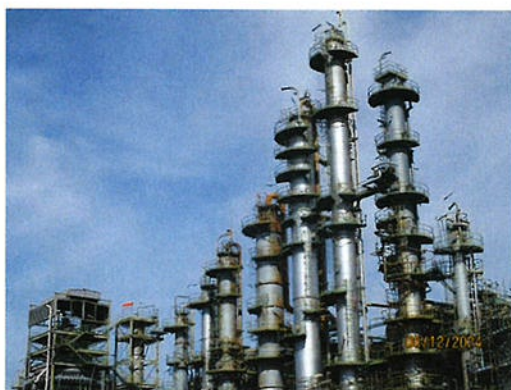
ภาพที่ 2-5 หอกลั่น Import EDC Distillation Column
