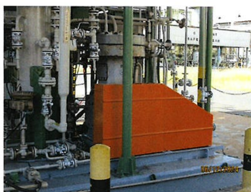
ภาพที่ 2-4 ปั๊มชนิด Double Mechanical Seal
