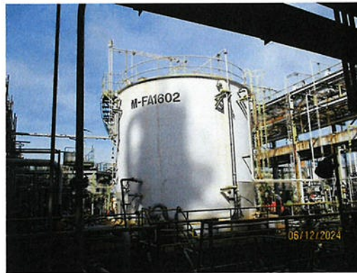
ภาพที่ 2-10 ถังเก็บน้ำปนเปื้อน
