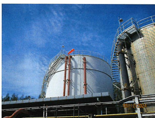
ถังน้ำดับเพลิงสำรอง ขนาด 14,000 ลูกบาศก์เมตร
