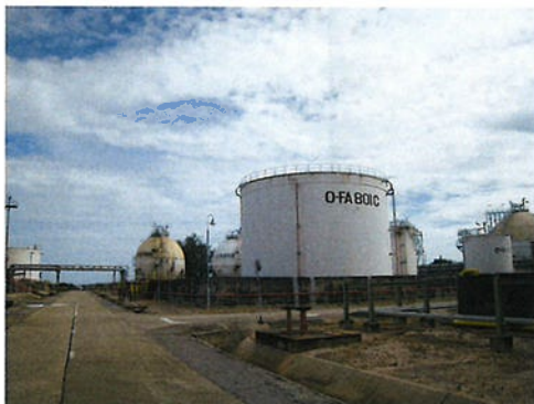
ภาพที่ 2-42 คันกั้นสำหรับถังเก็บกัก บริเวณลานถังที่ท่าเทียบเรือ ของบริษัท พีทีทีโกลบอล เคมิคอล จำกัด (มหาชน)
